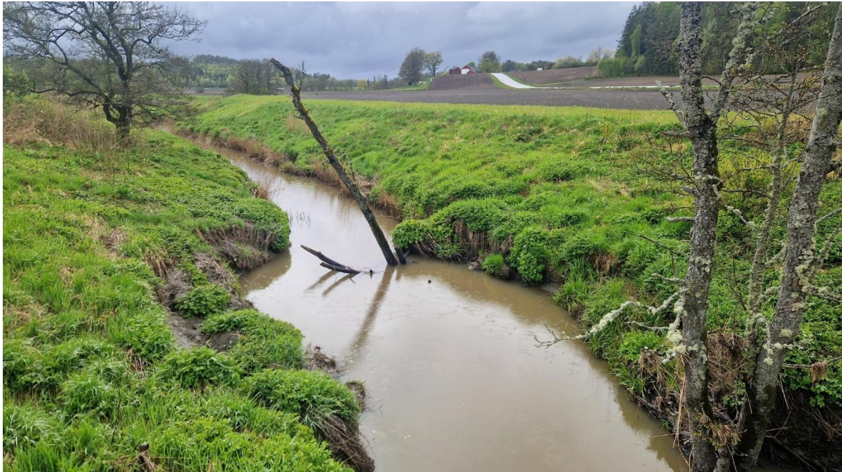
Gamle trær som eroderer og faller ut i bekkeløpet
