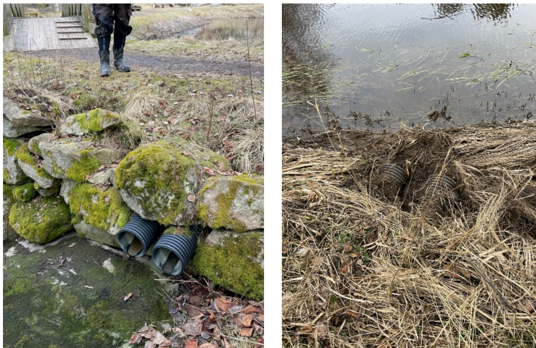
Figur 6 Overvannsrør under stien ved trebroa nedstrøms Mølledammen og innløpet i Mølledammen
