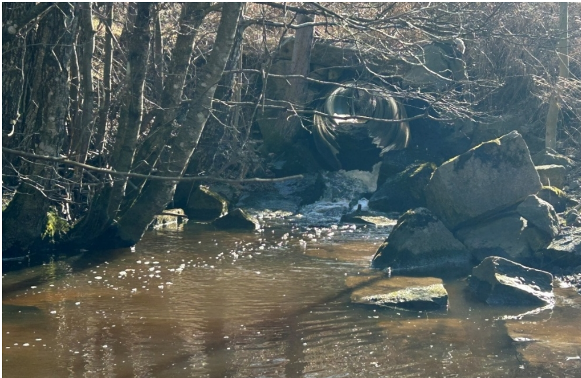
Figur 4 Utløpet til kulvert under Ytterstadveien
