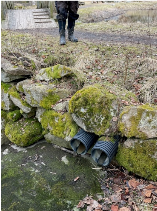
Figur 8 Overvannsrør under stien ved trebroa nedstrøms Mølledammen og innløpet i Mølledammen
