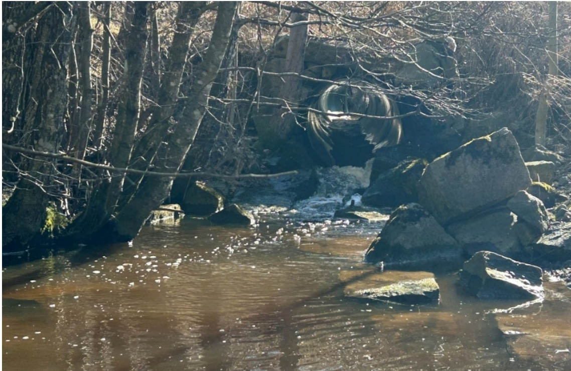
Figur 6 Utløpet til kulvert under Ytterstadveien
