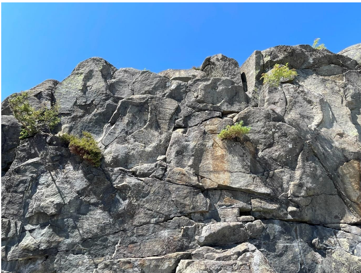
Figur 8. Oppsprukket berg og vegetasjon som vokser ut fra sprekker.
