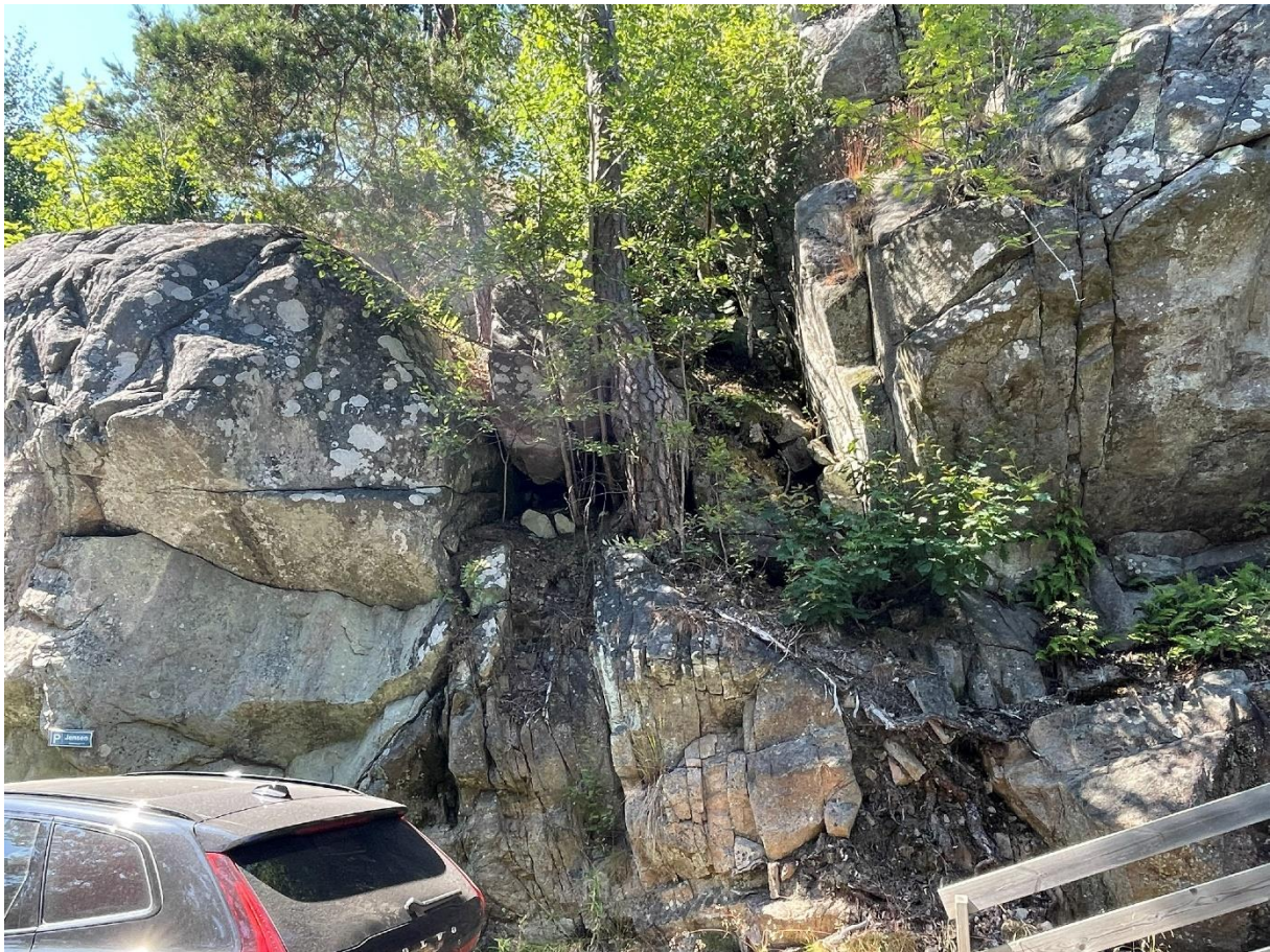
Figur 2. Oppsprukket berg, løse steinblokker og vegetasjon langs veien til parkeringsområdet.
